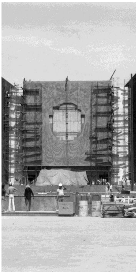
Obreros en la construcción del palacio, 1981.
